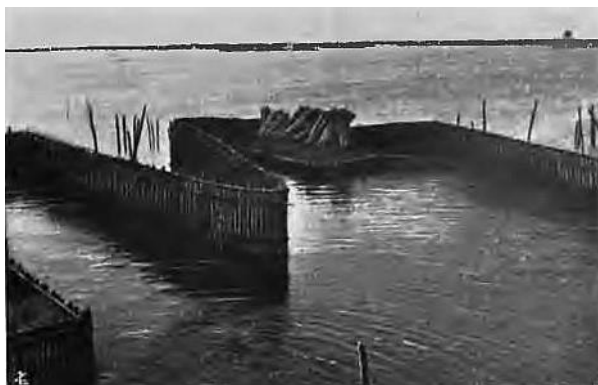
Costruzione di un lavoriero in valle semi-arginata
