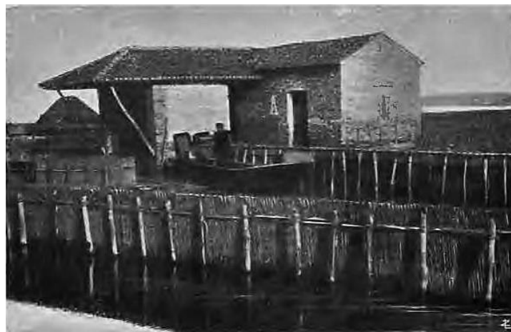
Valle Boccavecchia. Il magazzino per la lavorazione del pesce e barca all'approdo
