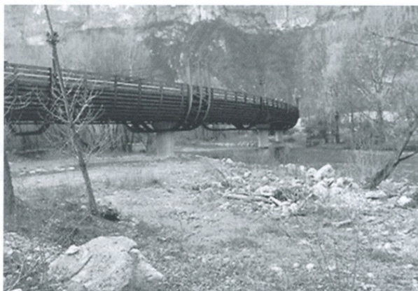
Fig. 2 – Il nuovo ponte che spacca in due il biotopo protetto La Rupe, Mezzolombardo; il biotopo è stato istituito dalla Provincia autonoma di Trento per la tutela della vegetazione ripariale (pioppi e salici) e di una popolazione di ululone a ventre giallo ( Bombina variegata ); ironia della sorte, il ponte è stato chiamato "ponte dell'ululone".
